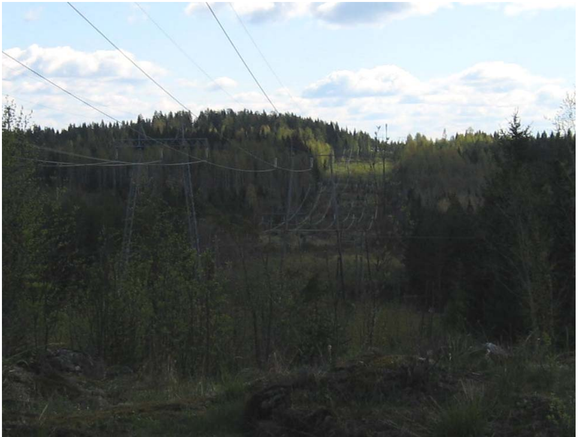
Kuva 6. Pataharju. Kuvattu itään päin maantieltä. Uusi voimajohto sijoittuisi voimajohtojen oikealle puolella
