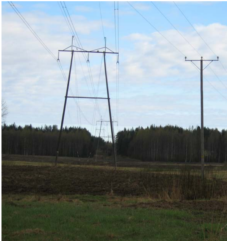
Kuva 12. Puntarikoski. Uuden 400 kV voimajohdon sijoittuminen 110 kV voimajohdon rinnalle voi vaihtua puolelta toiselle asutuksen, muun aluevarauksen tai rakennetun infrastruktuurin läheisyydestä johtuen. Kuvassa uusi johto sijoittuisi nykyisen johdon oikealle puolelle.
