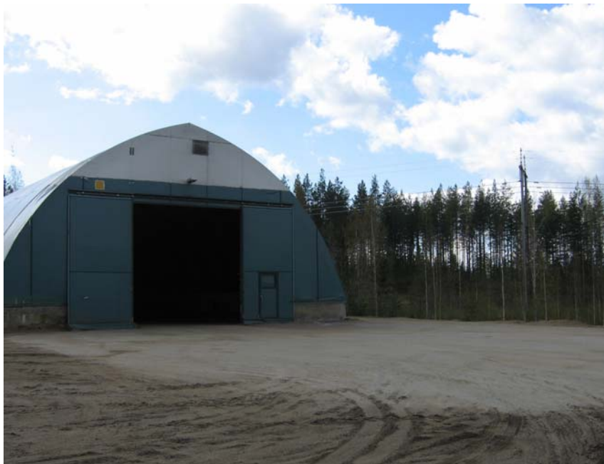
Kuva 18. Polvijärvi Outokummuntie. Tielaitoksen huoltorakennus on hyvin lähellä nykyistä johtokatua.
