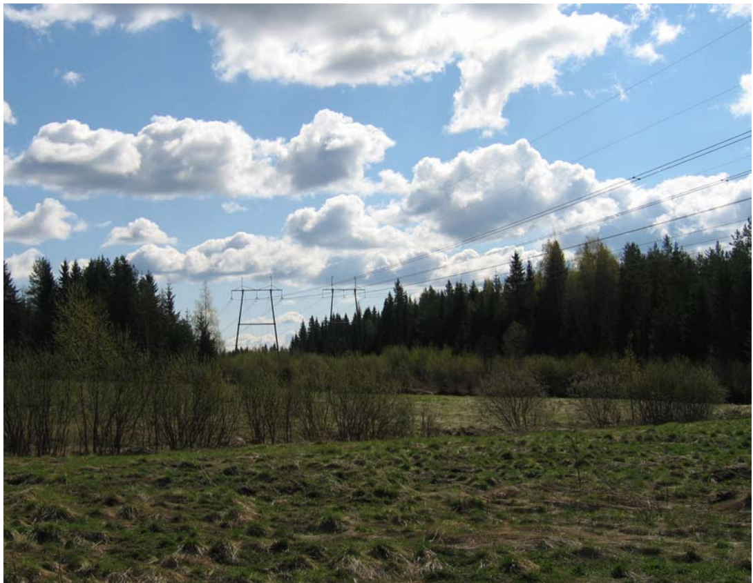
Kuva 14. Pataharju. Voimalinja Alavan tilan kohdalla.
