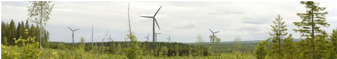
Kuva: Tuulivoimalat Sammakomäeltä katsottuna.
