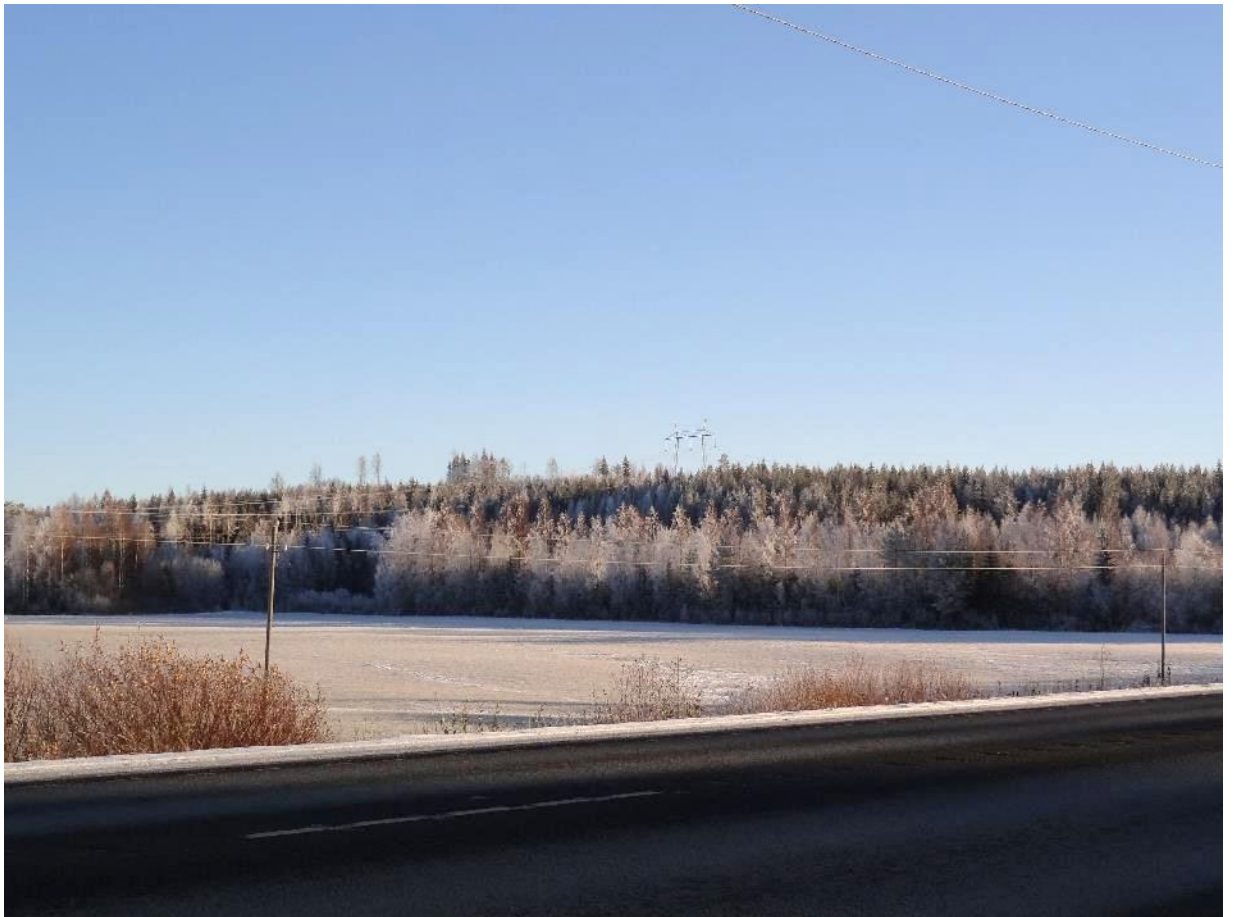
Kuva 16. Voimajohdot erottuvat jo kaukaa esimerkiksi tiealueilta. Kuvassa on nykyinen 400 kilovoltin voimajohto Kuopion tieltä (5-tie) kuvattuna. Uusi 400 kilovoltin voimajohto erottuisi vastaavana elementtinä nykyisen rinnalla.
