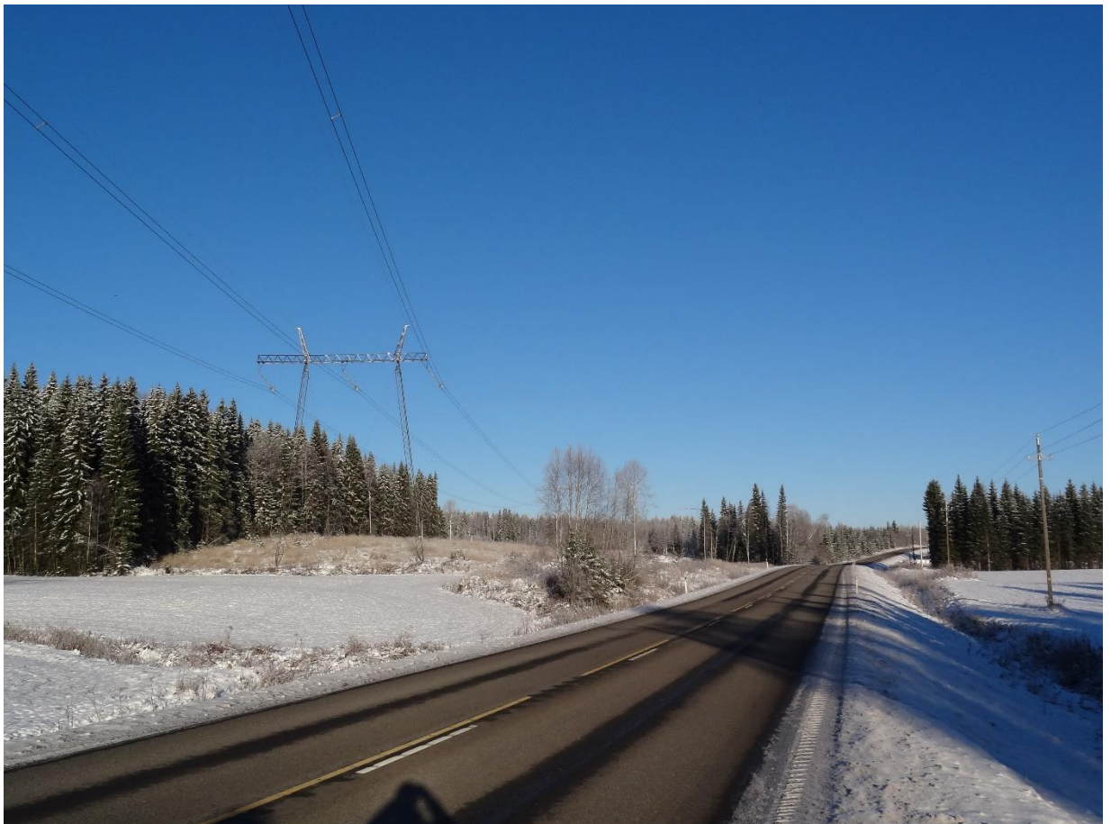
Kuva 26. Taustaselvitettävä voimajohto ylittää Kajaanintien nykyisen 400 kilovoltin voimajohdon kanssa.
