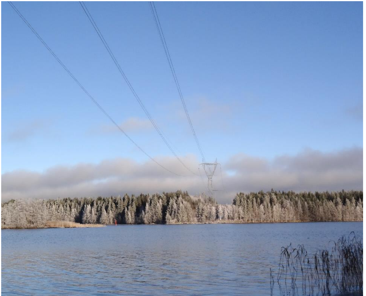
Kuva 14. Nykyinen Huutokoski – Alapitkä 400 kilovoltin voimajohto. Taustaselvitettävä voimajohto on suunniteltu sijoittuvaksi nykyisen voimajohdon itäpuolelle (kuvassa nykyisen voimajohdon oikealle puolelle). Kuva Pohjois-Kallaveden Sikolahdelta Petynsaaren suuntaan.
