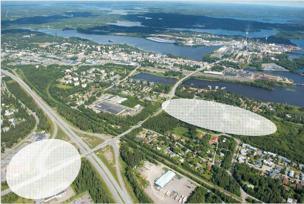
Kuva 25. Näkymä valtatien 23 liittymäalueelta ja Käärmeniemestä (Lento-kuva Vallas Oy).
