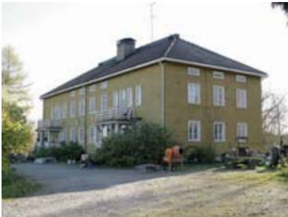
Kunnalliskoti, kuva: Arkkitehtitoimisto Hannu Puurunen Oy
