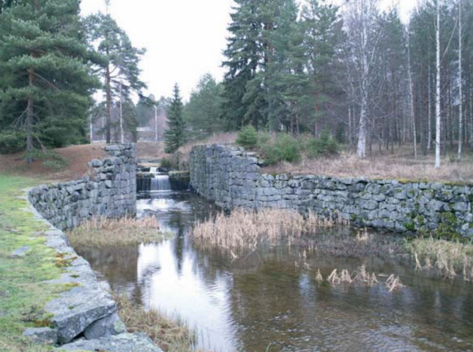
Taipaleen kanava, kuva: Arkkitehtitoimisto Hannu Puurunen Oy
