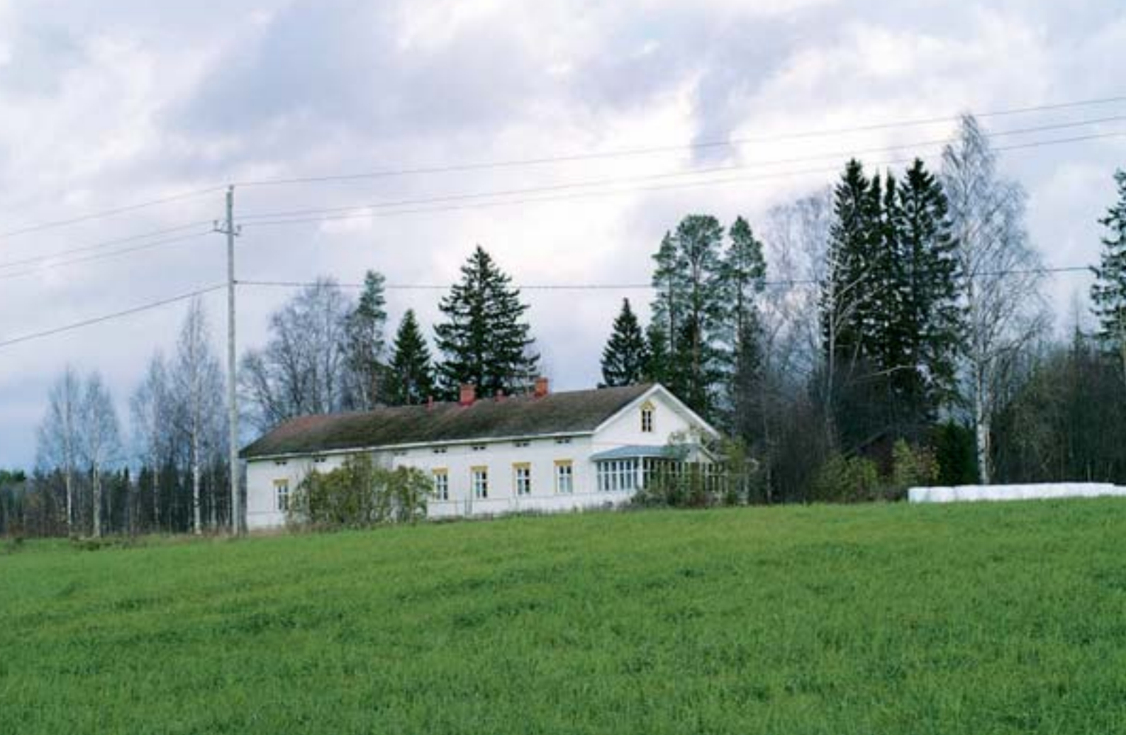
Onnela, kuva: Arkkitehtitoimisto Hannu Puurunen Oy
