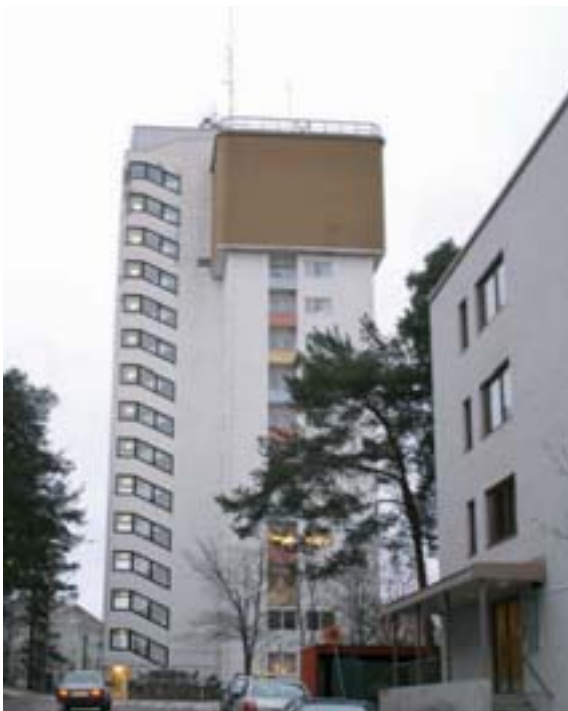
Vesitorni, kuva: Arkkitehtitoimisto Hannu Puurunen Oy
