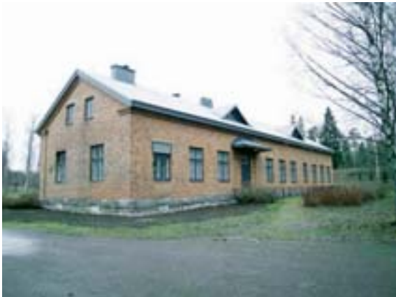
Entinen varikkorakennus kuva: Arkkitehtitoimisto Hannu Puurunen Oy
