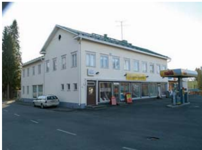
1950-luvun kauppa, kuva: Arkkitehtitoimisto Hannu Puurunen Oy
