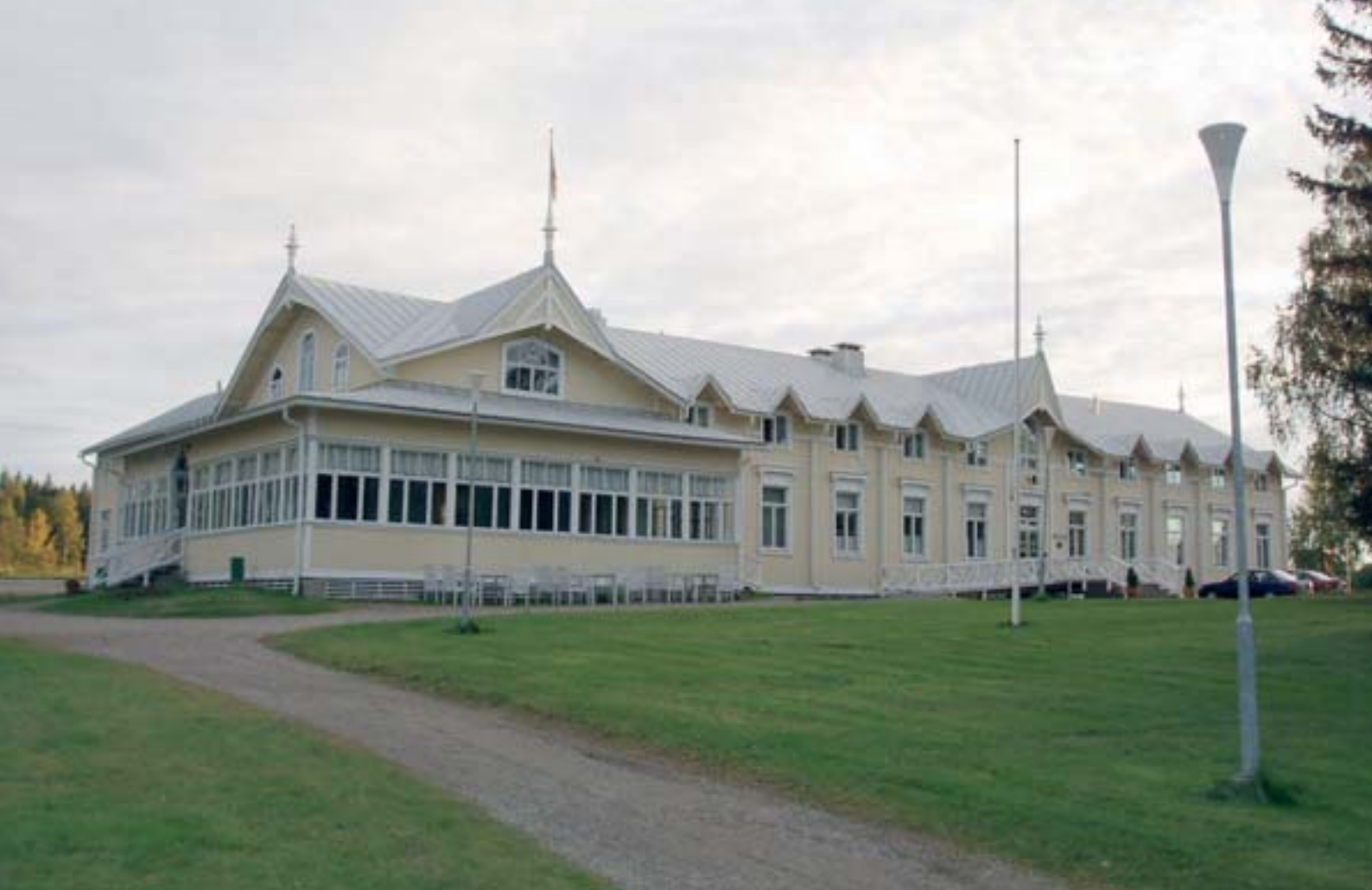
Runnin kylpylähotelli, kuva: Arkkitehtitoimisto Hannu Puurunen Oy
