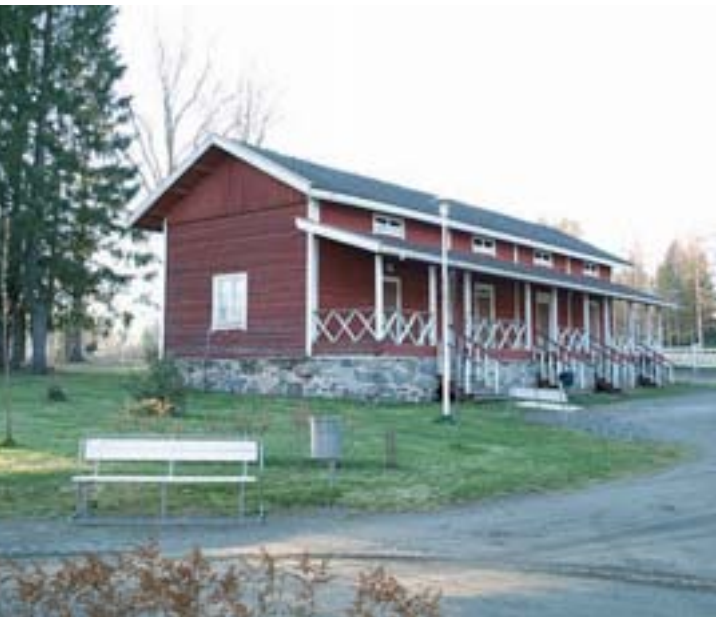
Riviaitta, kuva: Arkkitehtitoimisto Hannu Puurunen Oy
