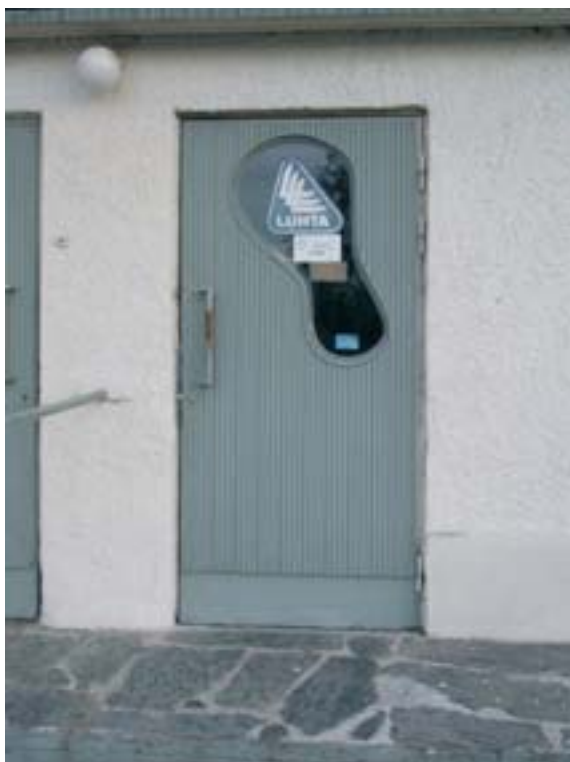
Vaatehallin ovi, kuva: Arkkitehtitoimisto Hannu Puurunen Oy
