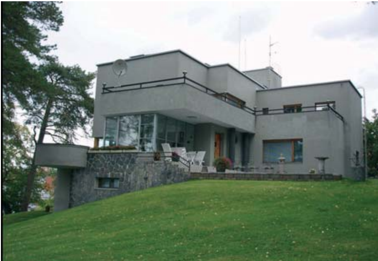
Olvin johtajan asuinrakennus, kuva: Arkkitehtitoimisto Hannu Puurunen Oy
