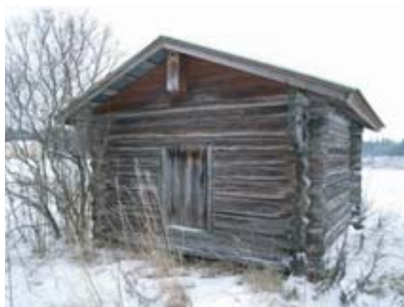
Ruisahon aitta, kuva: Arkkitehtitoimisto Hannu Puurunen Oy
