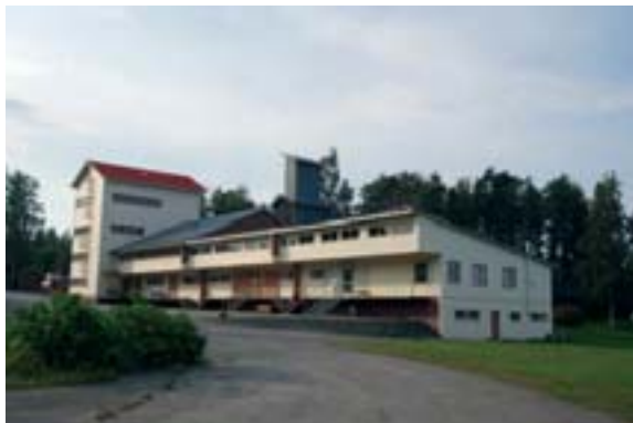
Säviän meijari ja myllyrakennus kuva: Arkkitehtitoimisto Hannu Puurunen Oy
