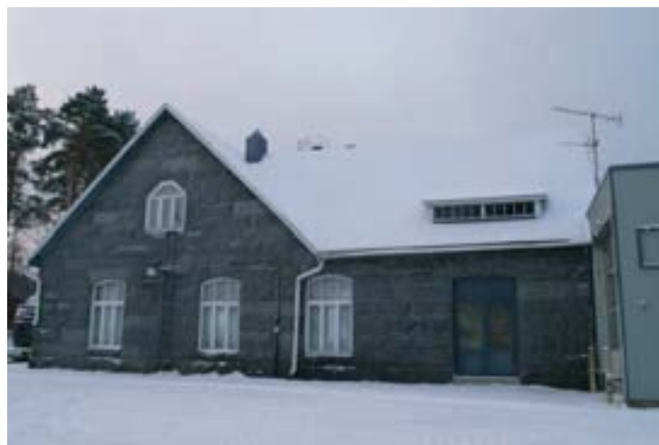
Niiniveden entinen meijeri, kuva: Arkkitehtitoimisto Hannu Puurunen Oy
