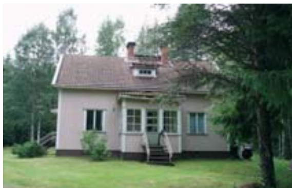
Karsikko, työnjohtajan asunto kuva: Arkkitehtitoimisto Hannu Puurunen Oy
