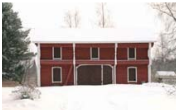
Korkeelan aitta, kuva: Arkkitehtitoimisto Hannu Puurunen Oy
