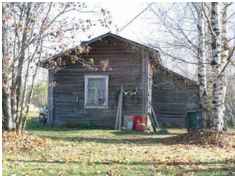
Taipale, kuva: Arkkitehtitoimisto Hannu Puurunen Oy
