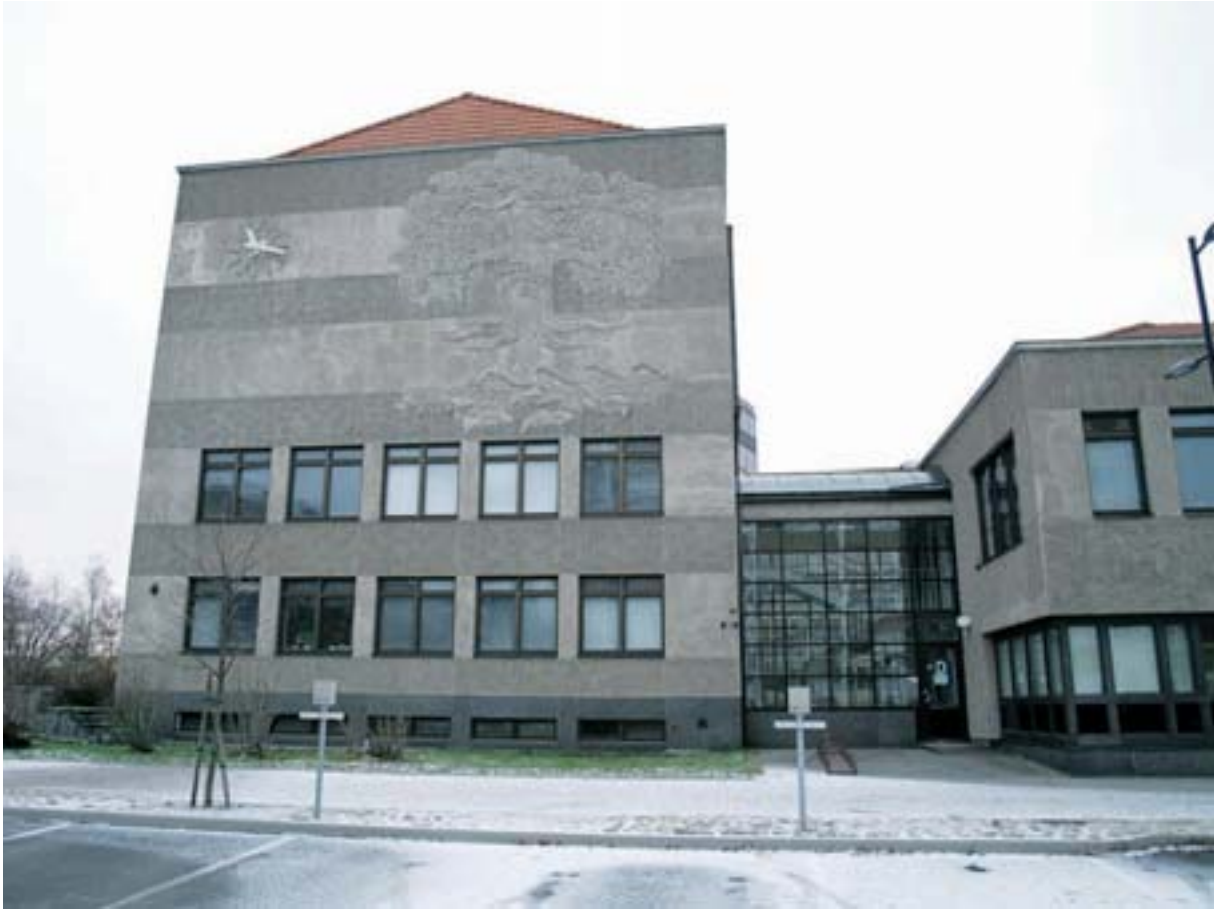
Kaupungintalon vanha osa, kuva: Arkkitehtitoimisto Hannu Puurunen Oy
