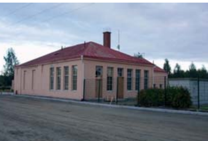
Sähkölaitoksen voima-asema kuva: Arkkitehtitoimisto Hannu Puurunen Oy
