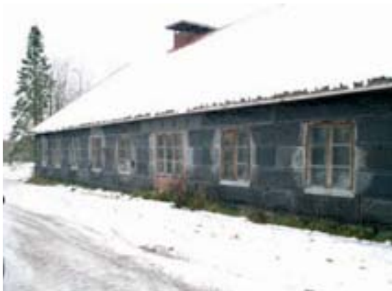
Pekkala, kuva: Arkkitehtitoimisto Hannu Puurunen Oy
