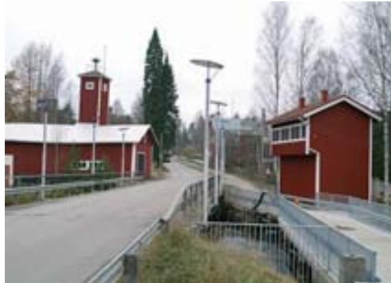
Paloasema, kuva: Arkkitehtitoimisto Hannu Puurunen Oy
