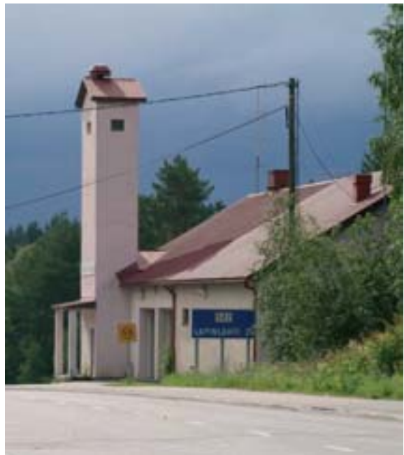
Paloasema, kuva: Arkkitehtitoimisto Hannu Puurunen Oy
