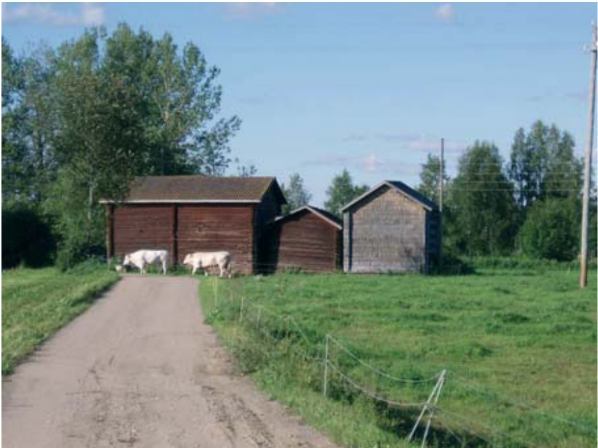
Postitalon aittoja, kuva: Arkkitehtitoimisto Hannu Puurunen Oy
