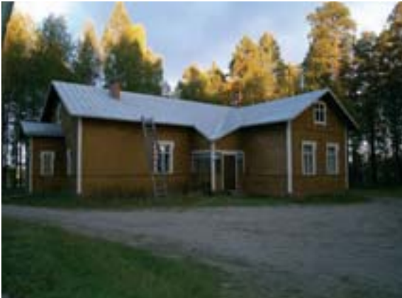
Entinen Ala-Luostan koulu, kuva: Arkkitehtitoimisto Hannu Puurunen Oy
