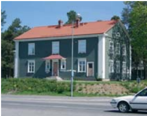
Vanha kunnantalo, kuva: Arkkitehtitoimisto Hannu Puurunen Oy
