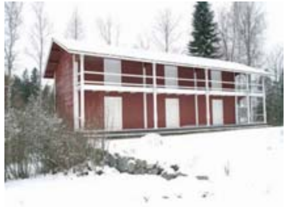
Ropola luhtiaitta, kuva: Arkkitehtitoimisto Hannu Puurunen Oy
