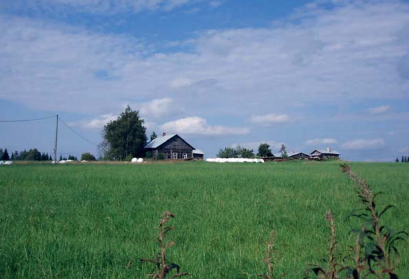
Katajamäki, kuva: Arkkitehtitoimisto Hannu Puurunen Oy
