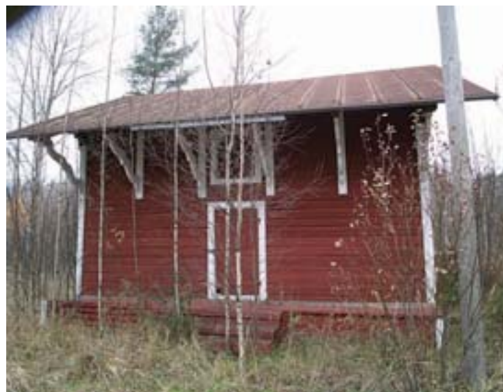
Viljamakasiini, kuva: Arkkitehtitoimisto Hannu Puurunen Oy
