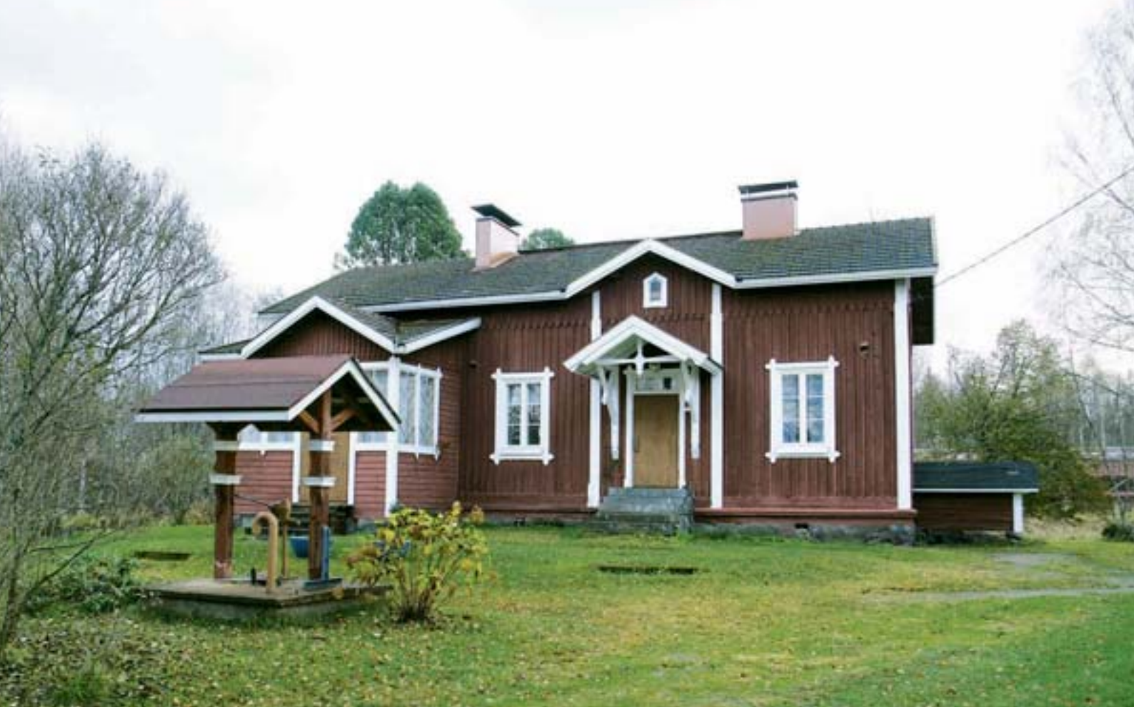
Salmisen asema-alue, kuva: Arkkitehtitoimisto Hannu Puurunen Oy
