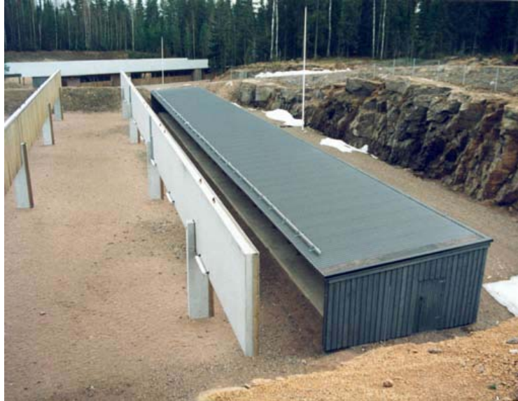
Puolustusvoimien ampumaradan rakenteita
