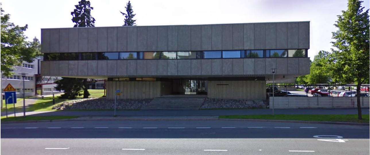
Itä-Suomen hovioikeus edustaa linjakasta betoniarkkitehtuuria.
